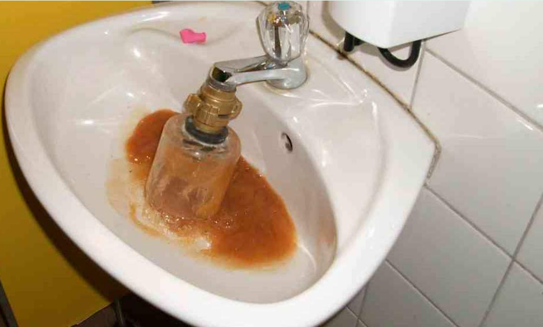
Comprex®-Reinigung als Sanierungskomponente in kontaminierten Systemen
