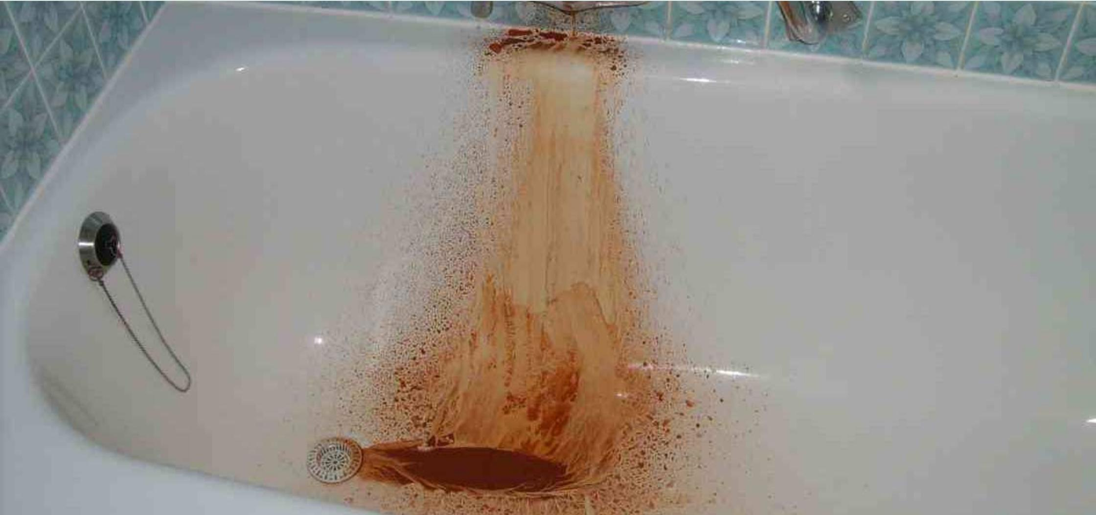
Comprex®-Reinigung als Sanierungskomponente in kontaminierten Systemen
