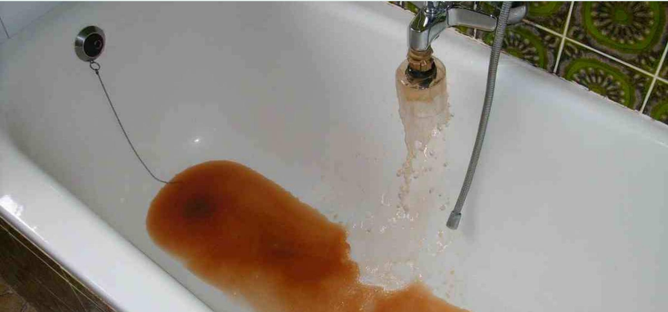
Comprex®-Reinigung als Sanierungskomponente in kontaminierten Systemen
