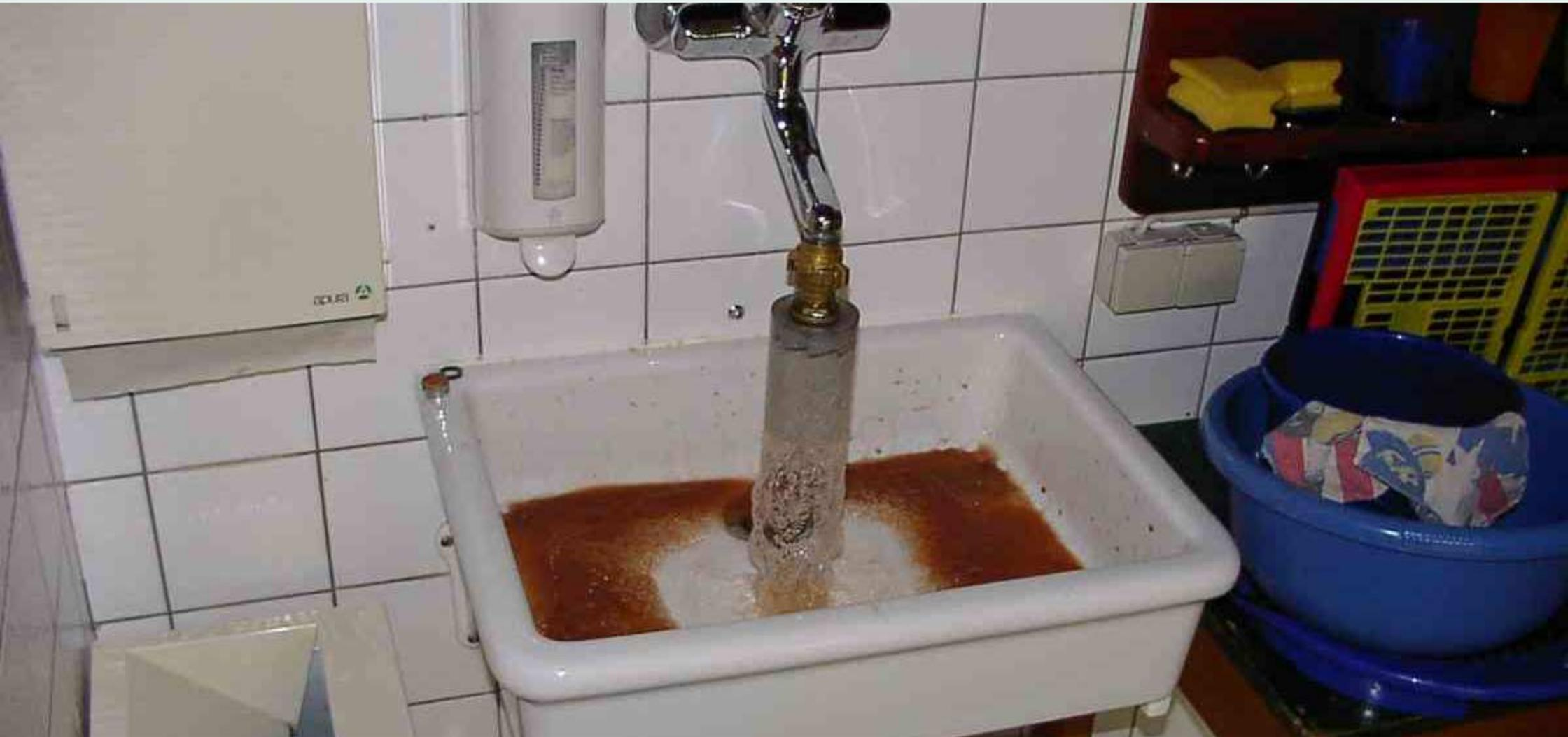
Comprex®-Reinigung als Sanierungskomponente in kontaminierten Systemen
